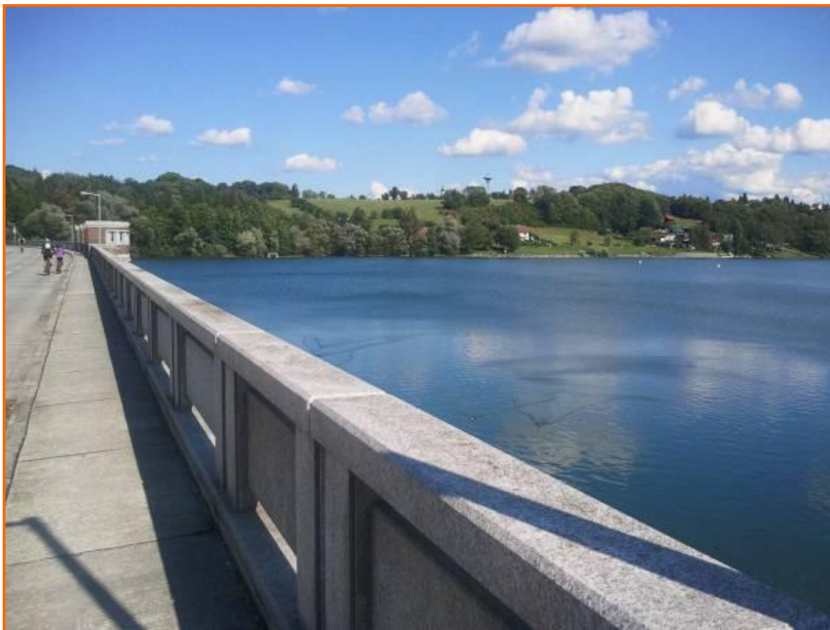
Obrázek 5: Vodní nádrž Žermanice 15
